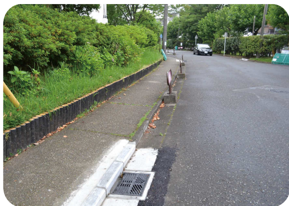
設置例（横浜市青葉区たまプラーザ住宅付近）
