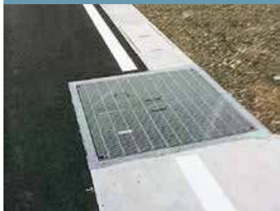
▲山梨県南アルプス市
