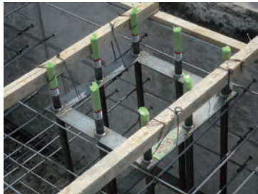
④アンカー筋設置
