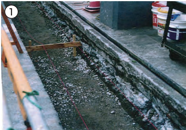
① 基礎碎石 敷設
