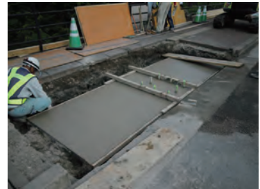
⑥仕上げ・養生
