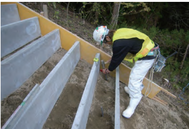
3.アンカー敷設
