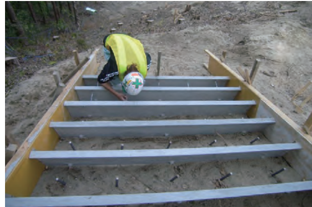
4.アンカー筋を本体インサートに固定
