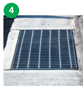
グレーチング設置
