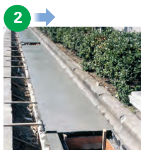
コンクリート打設
