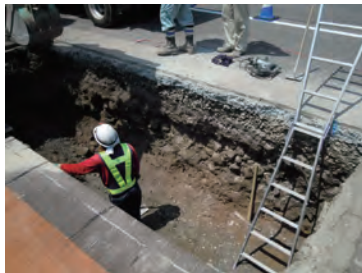
①掘削状況
