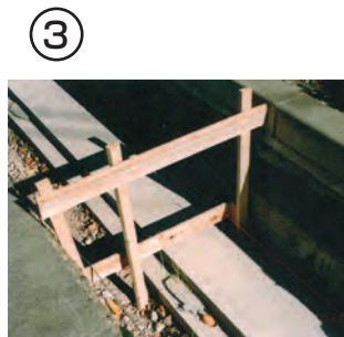
③ インバートコンクリート 打設
