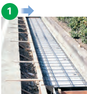
KCフォームの上に配筋した状態
