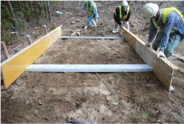
1.側面コンパネ設置
