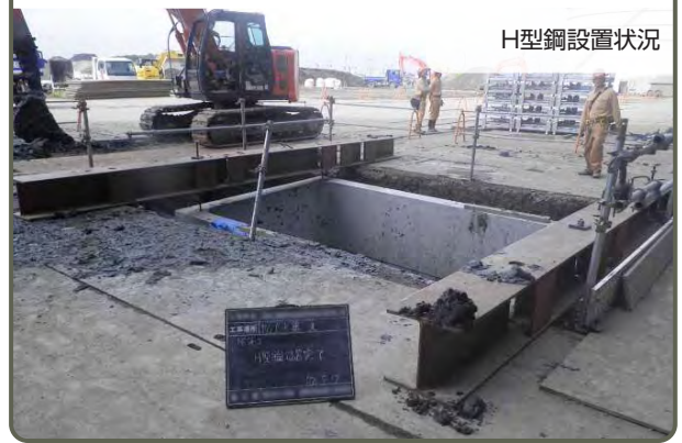
潜函工法(機械掘削状況)
