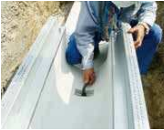
④ 固定ボルト締め
