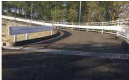
相武国道事務所
