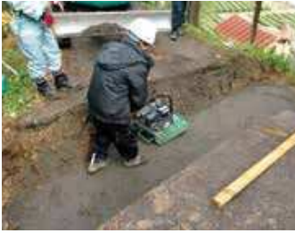
① 基礎材敷設
