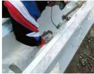
⑤ 連結部モルタル詰め
