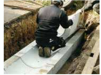
③ 側溝据え付け
