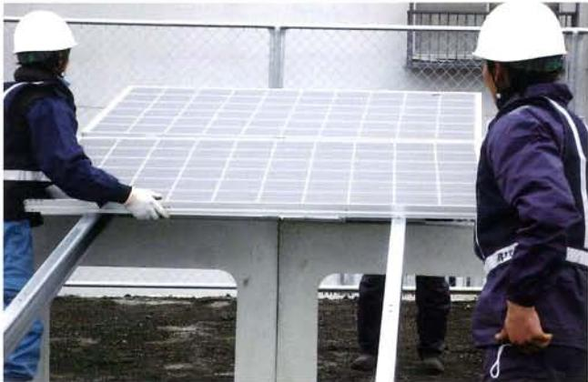
モジュールを取り付け、受材を固定します。
