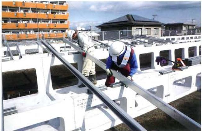
設計に合わせてレールアンカー取付け(後付けレールタイプのみ)、モジュール受材の取付けを行います。
